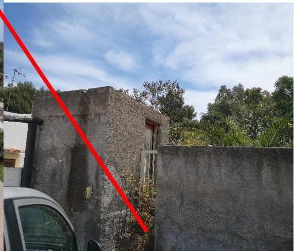
Ingresso laterale sul Sub.5 (B.N.C.)
